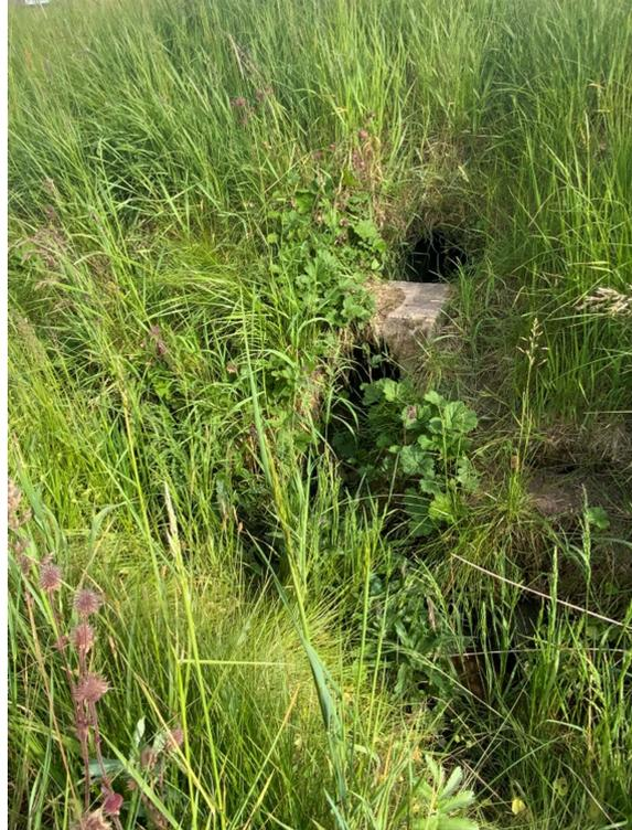
Die Einleitstelle befindet sich direkt im Bereich des Grundgrabens, der einen naturnahen Verlauf mit dichtem, gut ausgebildetem Uferbewuchs aufweist. Der Graben ist grundsätzlich funktionsfähig und zeigt keine Anzeichen von Erosion oder Auskolkung im Gewässerbett.
